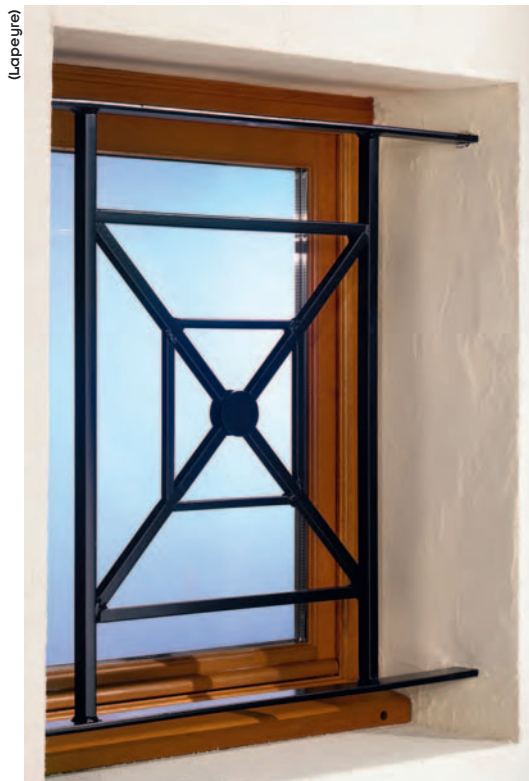
Une grille installée devant les petites fenêtres peut limiter le risque d'intrusion malvenue.
